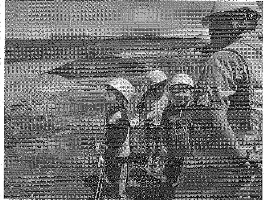
あまりに広い工事現場に驚く白鳥台小の1年生
